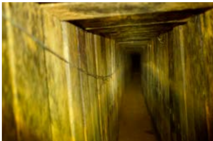
Figura N° 10: "Túnel subterráneo excavado por Hamás".
